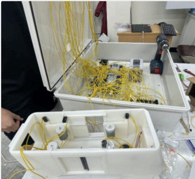
컨트롤 박스 내부 배선 작업
